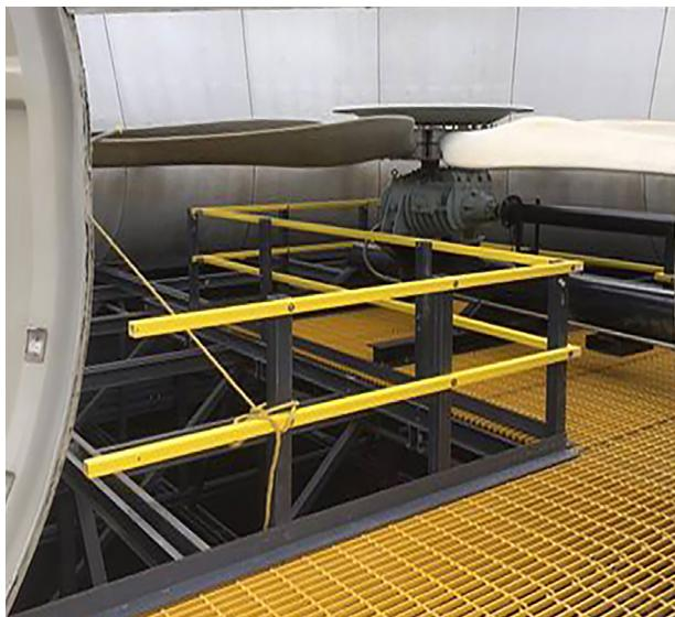
Permita que el personal realice sus tareas de manera segura. Instale la plataforma y la pasarela de mantenimiento en su torre de enfriamiento y mejore la seguridad del entorno laboral.
